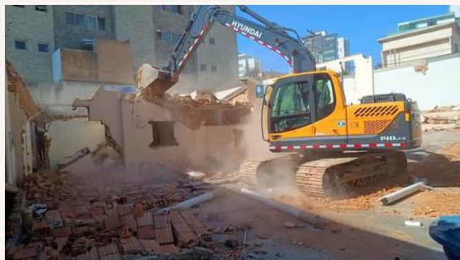
Demolição do templo
